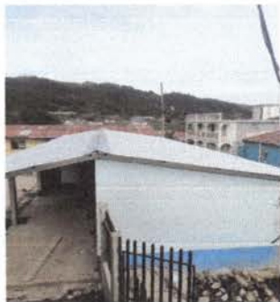
Foto1: Sustitución completa de las costaneras y lamina viejas por nuevas.
