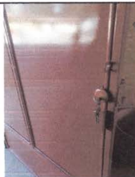
Foto 2: Finalización de sustitución de chapa y mejoramiento de puerta.
